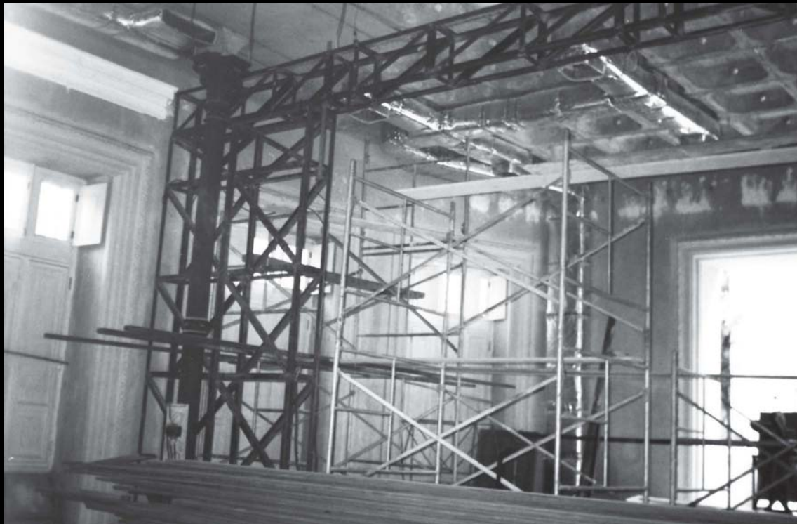
Teatro do Palácio da Justiça Federal. À esquerda, a estrutura da boca de cena
