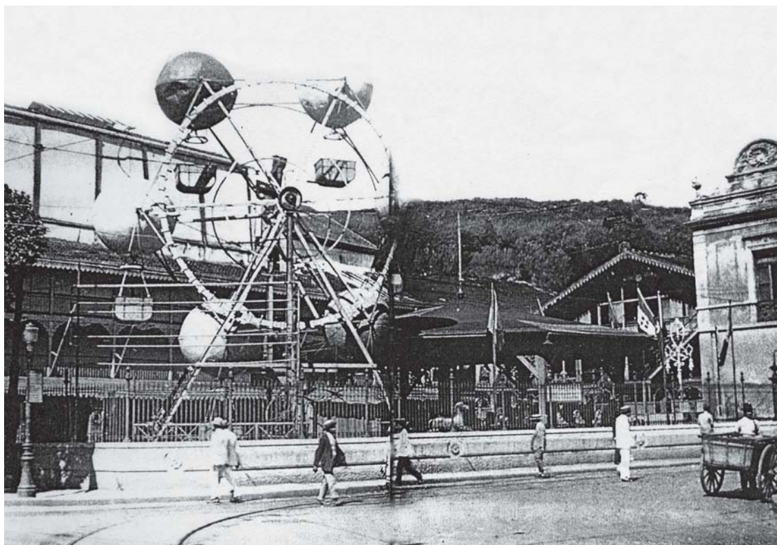
Maison Moderne. A sala de espetáculo era o penúltimo prédio
