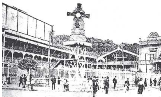
Maison Moderne. A sala de espetáculo era o penúltimo prédio
